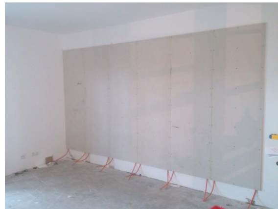
Fertig montierte flex-therm-Wandheizung
