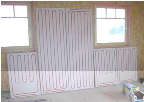
Montagevorbereitung auf Trockenbauwand
