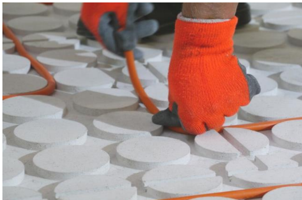
Bild 6 Biegen des Rohres an der Noppe
