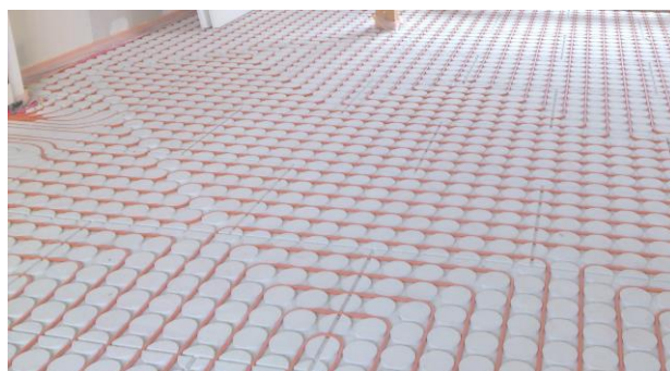
Bild 9 Zum Vergießen fertig verlegte Fläche
