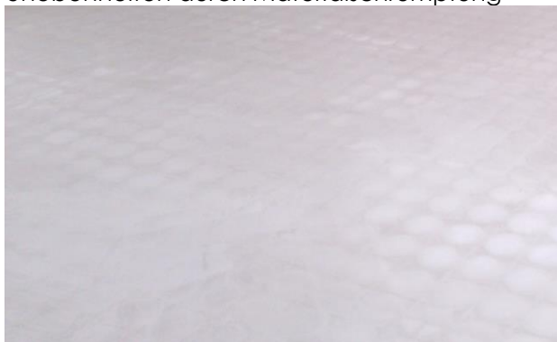
Bild 15 Zweilagig vergossene, ebene Fläche
