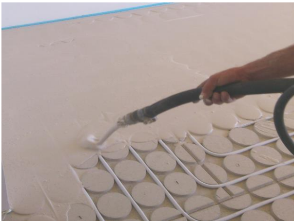
Bild 11 Verteilen der Masse mit Mörtelpumpe
