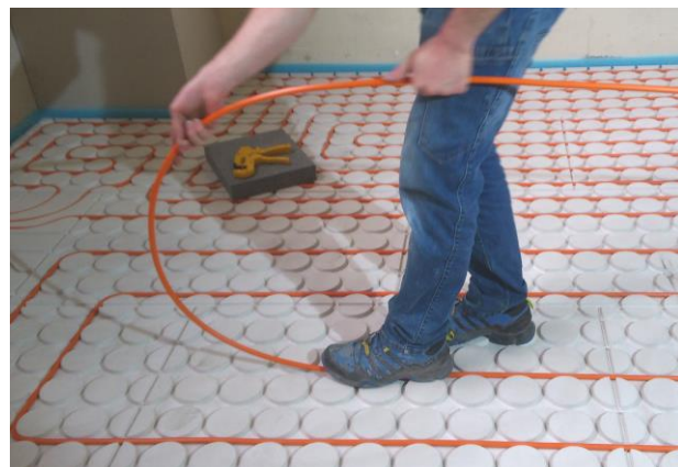
Bild 5 Einlegen der Rohre
