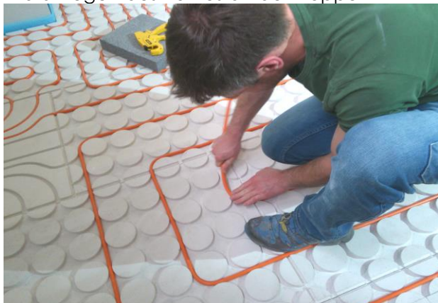
Bild 7 Biegen der Rohre an der Noppe
