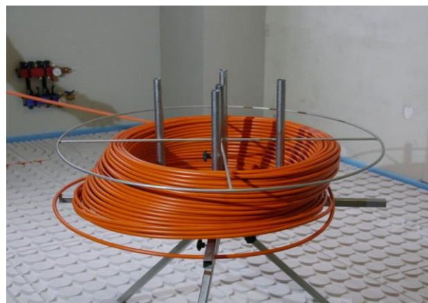
Bild 4 Rohr mit Abroller für Ein-Mannverlegung
