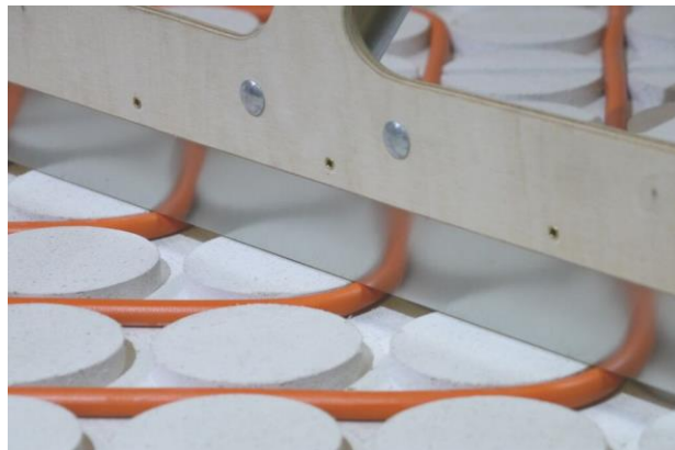
Bild 8 Prüfen der Rohrlage vor Auftragen der Vergussmasse – keinen Überstand zulassen!
