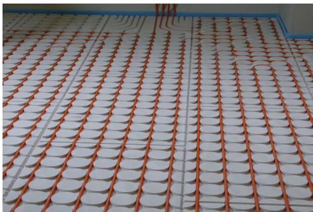
Bild 3 Fertig verlegte flex-therm FBH
