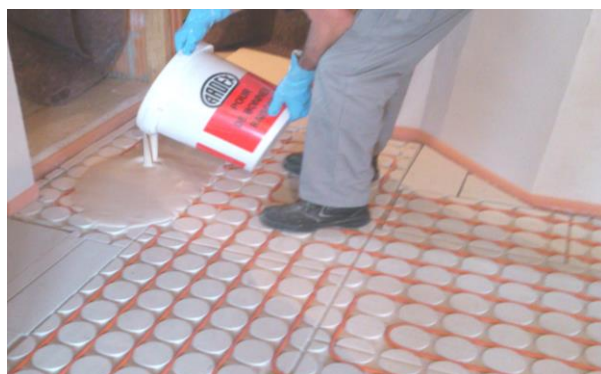
Bild 10 Ausgießen der Masse
