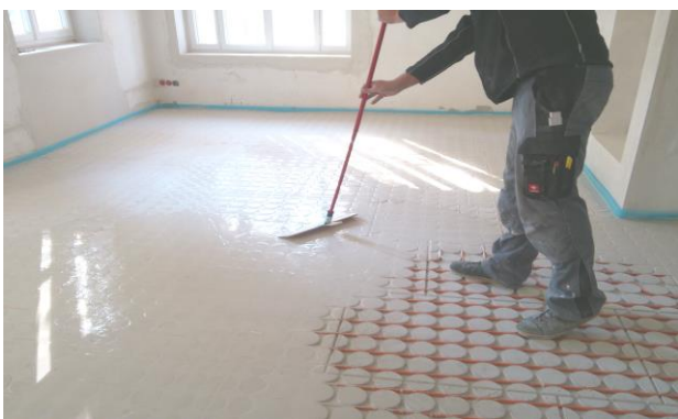
Bild 12 Verteilen der Masse mit Rake
